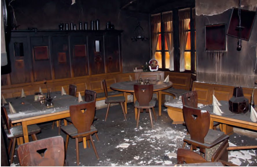
Ein Anblick, den kein Gastronom sehen will: Das Feuer hat den kompletten Betrieb zerstört. Doch dank des Versicherungsschutzes und der Beratung durch Fritz&Fritz kann Inhaberin Karin Molitor-Hartmann positiv in die Zukunft blicken.
